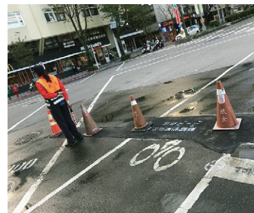
臨時辦公室，在光復南路口電力公司埋管，義交指揮交通。
