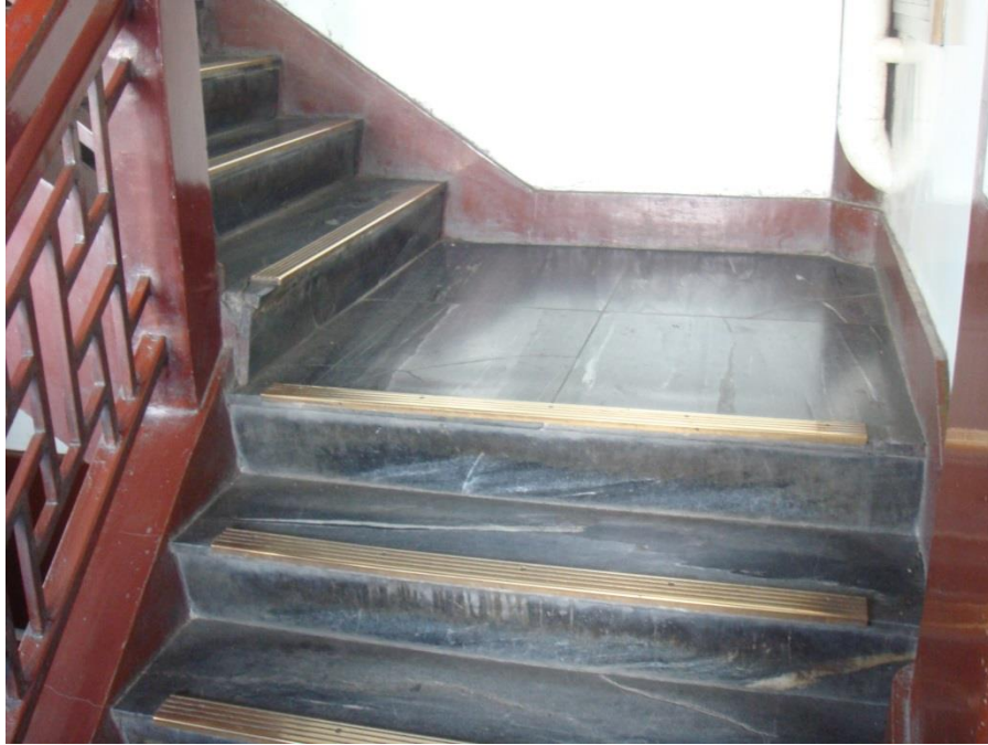
圖 11：黃鶴樓古蹟樓梯加置銅板壓條預防人員滑倒。
