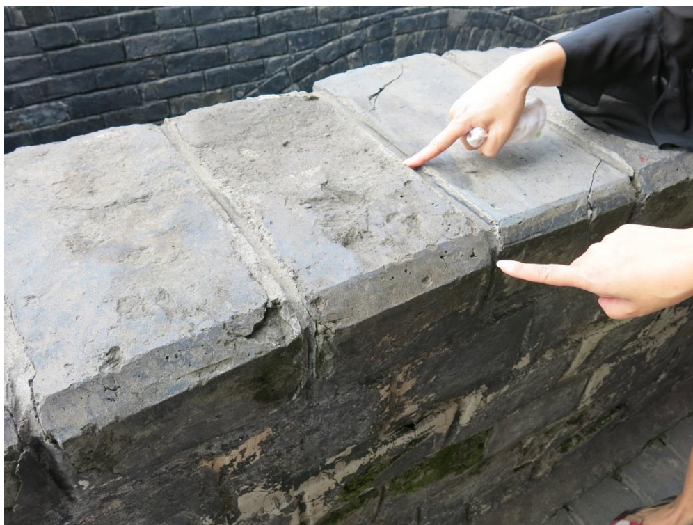
圖 3：起義門古蹟石磚切角設計成 135 度，防止民眾碰傷。
