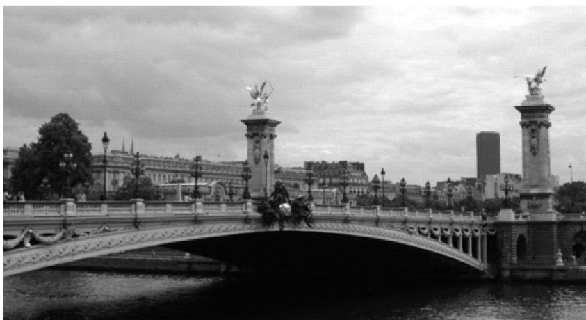
圖三 首次採用單跨鋼拱橋結構的亞歷山大三世橋，是19世紀末的建築工程奇蹟
