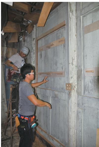
圖 23 彩繪牆板背面結構加固情況
