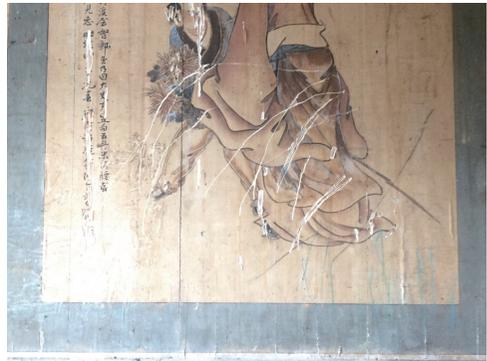
圖 2 彩繪牆板遭利器刮損後的樣貌
