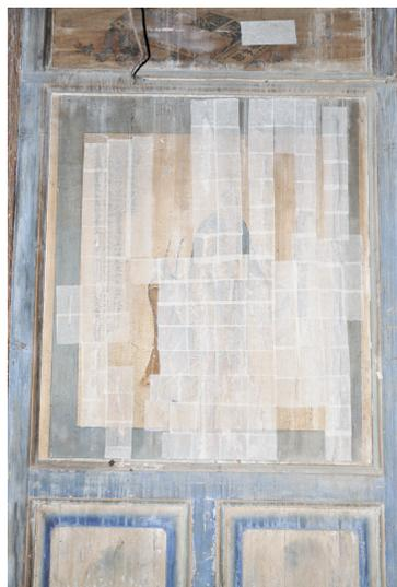
圖 18 暫時性加固完表面乾燥後
