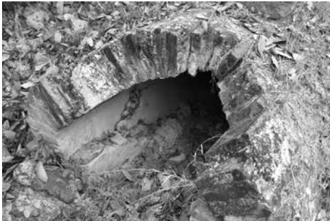
圖13 三腳埤的暗渠今貌，目前下半部分已埋沒在土壤中
