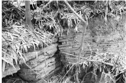
圖14 三腳埤堰堤中，三合土與磚瓦層交錯之處
