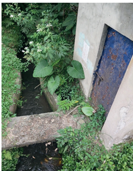
圖4 3號隧道入口旁的量水槽及置放量水儀的小屋
