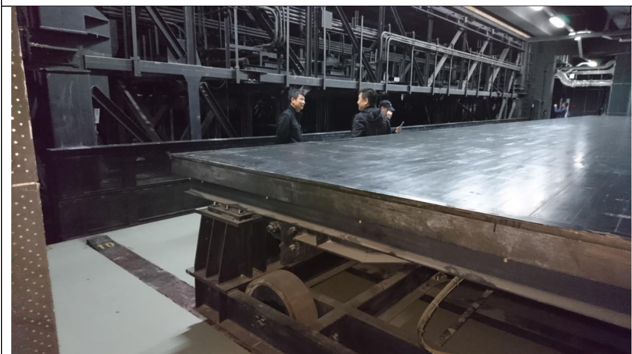
共計有一般地板、舞蹈地板、旋轉舞台等三面地板可以進行互換。
