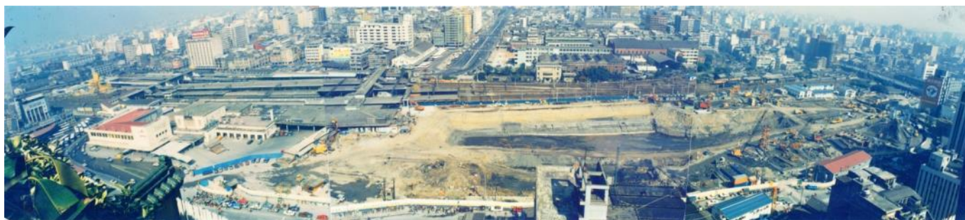
圖 3A 臺北鐵路地下化施工情形(資料來源：沈劭芸)
