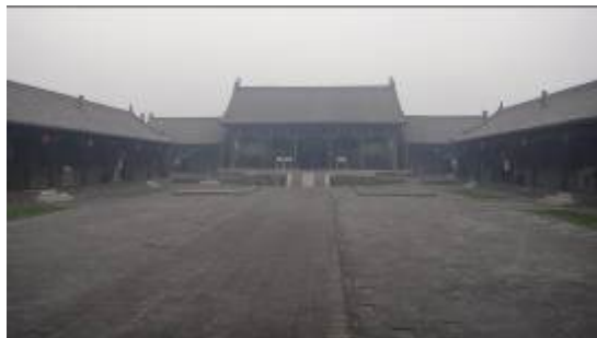
平遙縣衙對稱平衡的建築共有六進院落
