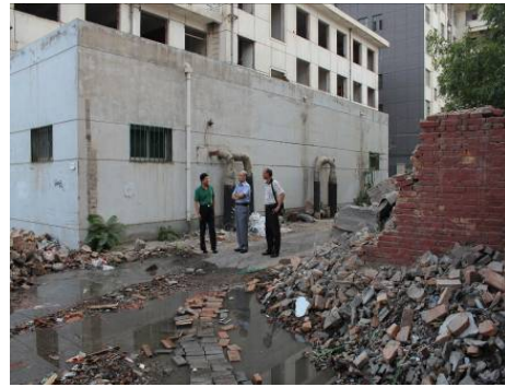
圖 14、寧夏京劇團舊場館拆除樣貌-1
