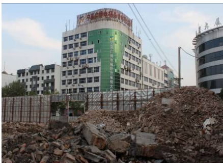
圖 15、寧夏京劇團舊場館拆除樣貌-2
