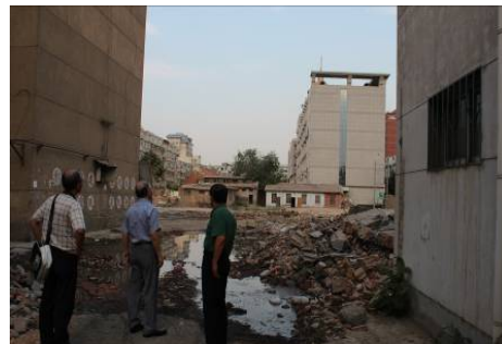
圖 16、寧夏京劇團舊場館拆除樣貌-3
