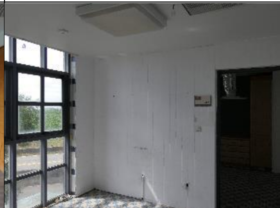
20. 2、3、4樓電梯儲物間
