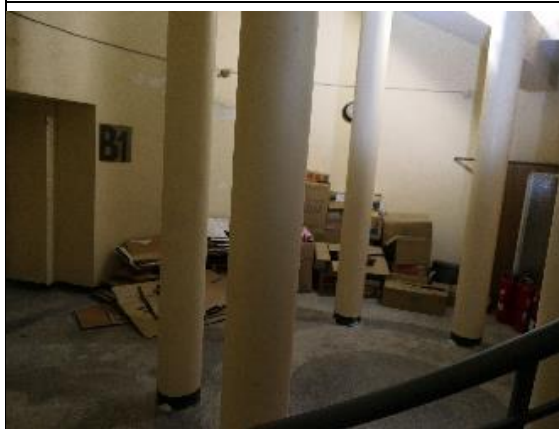
5. 地下室（樓梯空間）
