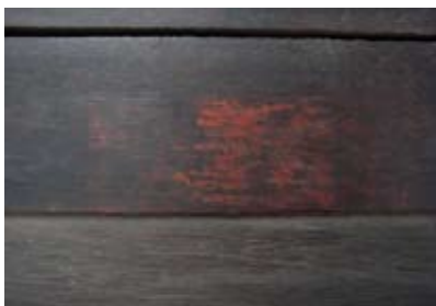
圖17 紙標籤殘跡移除後，部分塗層亦移除。 攝影日期：2011/03
