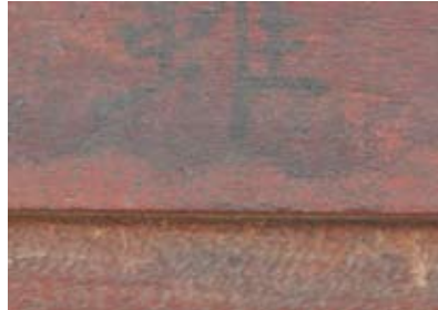
圖70 塗層垂流痕跡，此垂流塗膜應為附加塗層。
