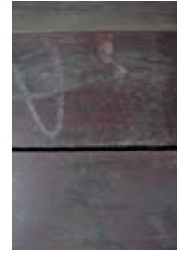
圖9 使用純水清潔前，髒污覆蓋塗層。 攝影日期:2011/03
