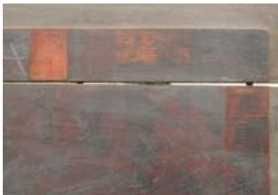
圖40 一般光下，塗層缺損處呈赭褐色。
