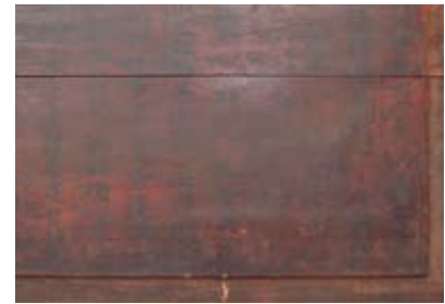
圖75 塗膜淡化前，因塗層較厚且有嚴重黃化與龜裂紋狀況，導致字跡隱蔽。
