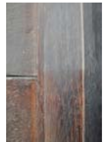
圖64 表面髒污清潔中；上半側為清潔前，下半側為清潔後。
