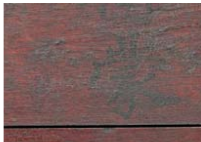
圖73 清潔後，塗層黃化及細裂紋狀況仍影響辨識字跡。
