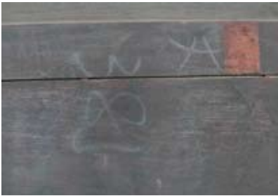
圖79 塗膜淡化前，因塗層較厚且有嚴重黃化與龜裂紋狀況，導致字跡隱蔽。
