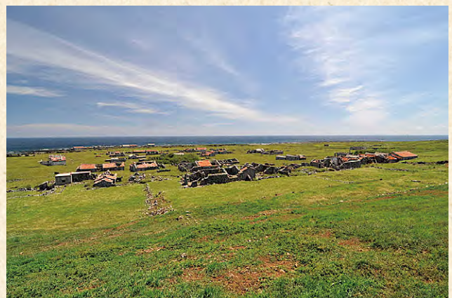
西吉嶼聚落遺構
