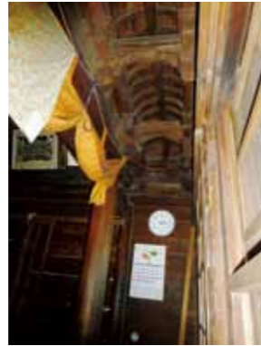
圖50 原為水戶藩常陸延方學校聖堂（大成殿）前面「庇」徹上露明造之捲蓬內部屋頂，圖片來源：黃蘭翔提供（2015.12.22拍攝）
