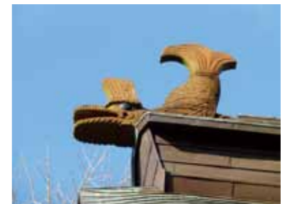
圖92 原為水戶藩常陸延方學校聖堂（大成殿）屋脊兩端脊飾。與朱舜水設計的鬼龍子（傍吻）不一樣，圖片來源：黃蘭翔提供（2015.12.22 拍攝）
