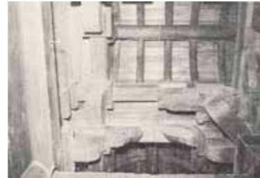
圖51 原為水戶藩常陸延方學校聖堂（大成殿）右側與前面庇交錯之角隅屋頂內部，圖片來源：城戶久、高橋宏之共著，《藩校遺構：江戸時代の学校建築と教育》，頁95。
