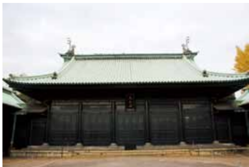
圖22 湯島聖廟(孔子廟)大成殿。無東階與西階之設置，圖片來源：黃蘭翔提供(2008.12.8拍攝)
