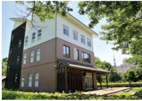
圖3 樂活節能屋的斜屋頂朝南傾斜23.5度，為臺灣獲取太陽能最好的角度，有助於提升屋頂上太陽能光電板的產電量能。(鄭春翔 攝)
