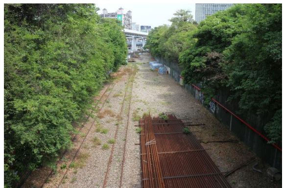
(圖 7)地下鐵緊急搶修出入口
