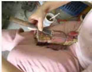
圖26 將腐朽處填入木粉並修平
