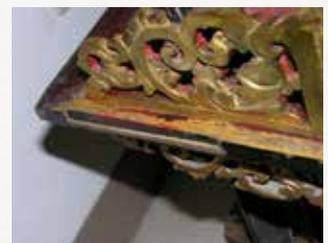
圖17 損毀處修補不良
