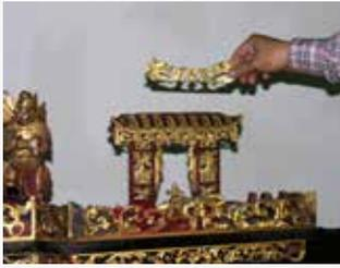
圖9 構件脫落
