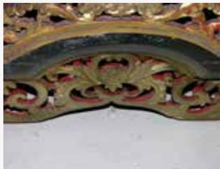
圖41 原構件為漆銅粉之情形
