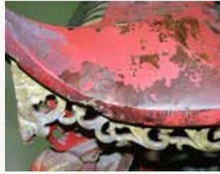
圖11 構件腐朽
