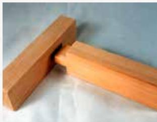
圖2「平頭榫」結構相片—分解
