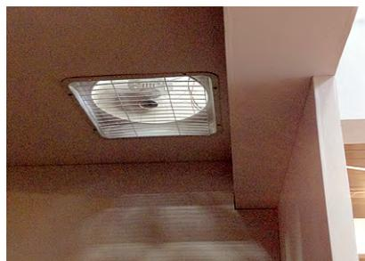
圖9 互動裝置展示隔間加裝風扇散熱
