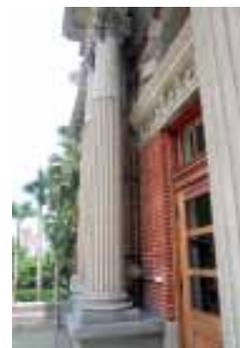
大門二樓的艾歐尼克柱，頂端除了有雙螺旋的紋飾，下面還有下垂的葡萄。這幾根柱子除了有裝飾的作用，還可以擋住後方突兀的排水管。
