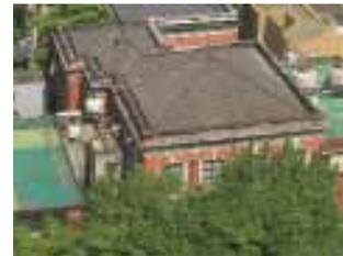
現在的皮膚部俯視圖，可看到日式黑瓦構成的屋頂與洗石子構成的裝飾橫帶，經過將近百年仍相當完整。屋頂有四個坡面是日式建築的特色，傳統臺灣建築只會兩個坡面。
