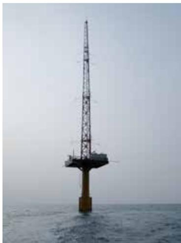
圖5 臺電公司位於芳苑外海9公里的海氣象觀測塔，塔頂高度達95公尺，為臺灣邁入離岸風力開發國家的重要里程碑。
