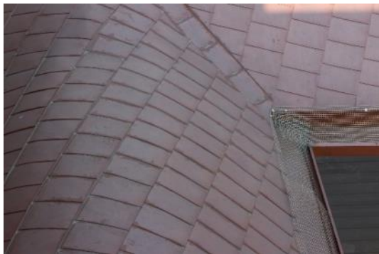
i. D 廊道屋面銅板瓦排列方式
