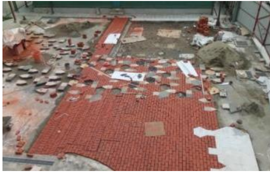
h. 廳舍北側小廣場鋪面紅磚施工中 先鋪石材、再鋪紅磚，最後填入黑瓦斷面拼花
