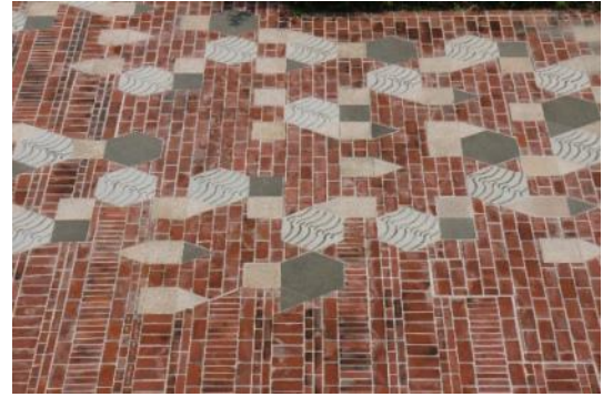
i. 廳舍北側小廣場鋪面完成 可見 Type1 和 4 的紅磚拼法及穿插其間、顏色相異的食材與黑瓦拼花。
