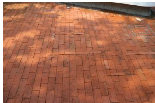
g. 工務室電源室之間Type1紅磚鋪面以及以豎磚分割作為拼花。
