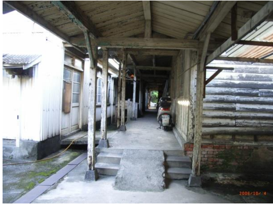
e. 工務室東側廊道原有小坡道(2006年10月4日攝)
