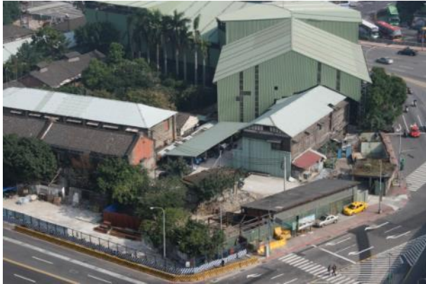
【圖 11】36 號建物之西側正由捷運工程拆除中(2007 年 12 月 17 日攝)
