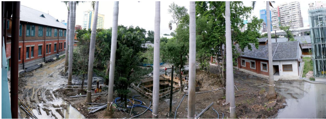
c. 雨水回收池施工情形
