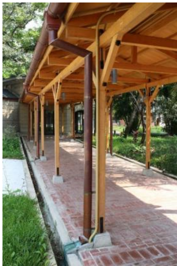
c. A 廊道的木構架及落水管、柱腳束石
