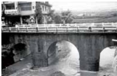
圖25 1996年以前，呈甘橋橋梁的圓拱結構。酒瓶狀欄杆已拆除，改成水平混凝土護欄，圖片來源：黃承令計劃主持，《新竹縣定古蹟關西東安橋及歷史建築芎林呈甘橋修復再利用計畫》，頁6-12。
