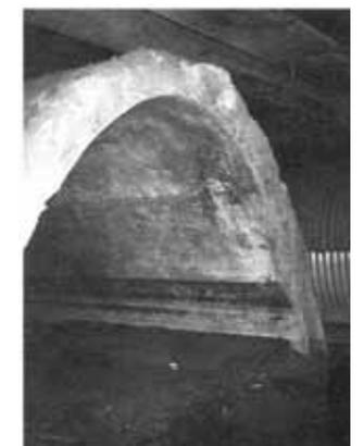
圖17 明治39年（1906）埋設於原清代臺北府城地下之馬蹄型排水管，圖片來源：李乾朗，《臺北府城牆及礮臺基座遺址研究》，頁31。
