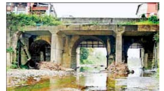
圖27 呈甘橋現貌。可以看見石砌橋梁與混凝土橋樑貼附於一起，圖片來源：「〈北部〉芎林呈甘橋暫定古蹟」，《自由時報》，2012.4.6。
