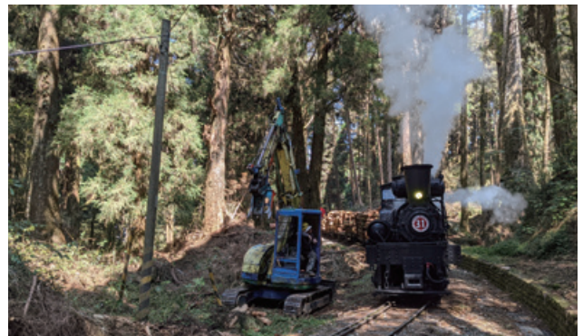
2021年水山線沿線進行疏伐作業時，重現蒸汽機車運材樣貌
