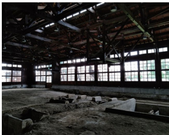
嘉義製材所第二代機具工廠木構造及設施遺構
