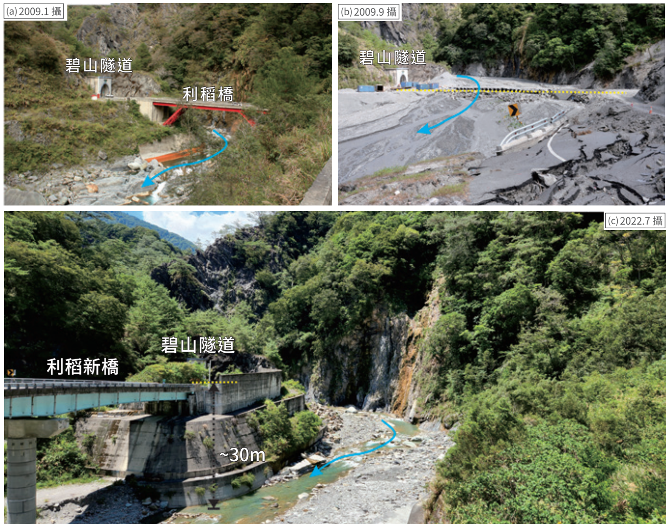
圖 9 觀察地點 4【利稻橋】。(a) 利稻橋在莫拉克風災前具有亮麗的紅色橋體，離溪床將近 30 公尺高，風景秀麗，很多遊客都會於此處駐足拍照留念；(b) 風災後利稻橋遭土石流沖毀不見，河床堆積大量的土石，泥沙高度甚至與一旁的碧山隧道口的路面相當；(c) 利稻新橋於 2012 年新建完成，溪水下切快速，現已恢復原先優美的景觀
