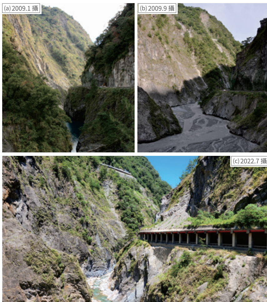
圖 8 觀察地點 3【霧鹿峽谷】。霧鹿峽谷是南橫沿線最壯麗的景致之一，莫拉克風災前峽谷中的碧綠清澈溪水；風災後取而代之的是淤泥礫石填滿河道，河床墊高將近 20 公尺；如今溪水重新清澈，壯麗峽谷景觀再現，特別的是峭壁上多興建了明隧道以保護用路人的安全
