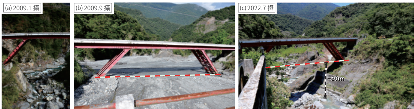
圖6 觀察地點2【霧鹿橋】。(a) 過去霧鹿橋的橋梁支座離河床約20公尺高；(b) 莫拉克風災過後，橋梁支座被大量土石掩埋(紅白相間線段為對應橋梁支座之位置)；(c) 如今沉積物被溪水沖刷帶走，溪床景觀已逐漸恢復舊觀(黑白相間線段示沉積物堆積高度)
