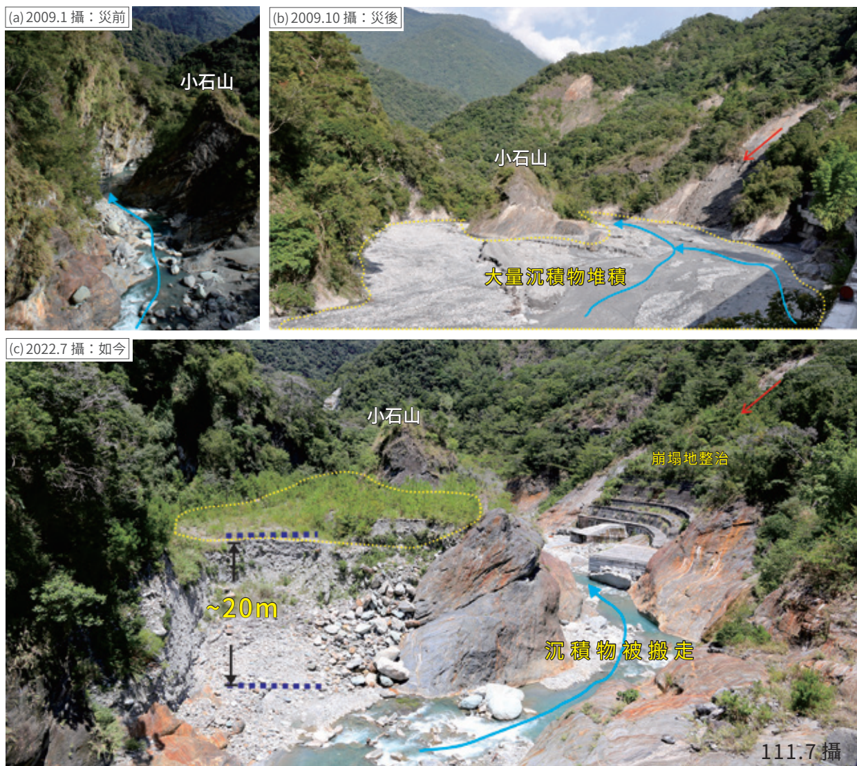
圖 7 觀察地點 2【霧鹿橋】。由霧鹿橋上向新武呂溪下游望去，即可見到莫拉克風災所留下最顯著的印記：(a) 風災前新武呂溪的舊河道，位於溪中小石山的北側（照片左側）；(b) 風災時大量洪水襲來，除了北岸溪谷被填滿，小石山南側形成新的河道（照片右側），風災當時所堆積的砂石將河道拓展為約 30 至 40 公尺寬；(c) 如今又變回原先的 V 型河谷，溪水改由小石山南側向東流，小石山北側則留下了莫拉克風災所堆積的河階，離現今河床面高約 20 公尺。（紫色虛線表示風災前、後不同時期之河床面，黃色虛線範圍風災時為堆積的沉積物範圍，如今變為階地）
