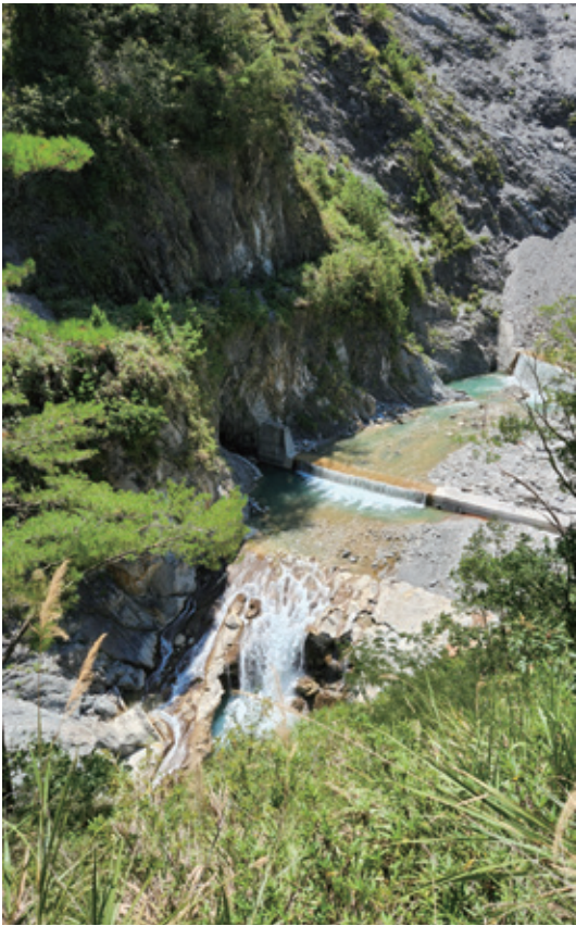
圖 10 觀察地點 4【利稻橋】。利稻橋下方，興建了 3 座防砂壩以穩固橋體，但由於防砂壩上游的河床面被抬高，溪水經過防砂壩後不斷侵蝕下切，使得防砂壩下方形成一處新的大型瀑布（攝於 2022 年 7 月）
